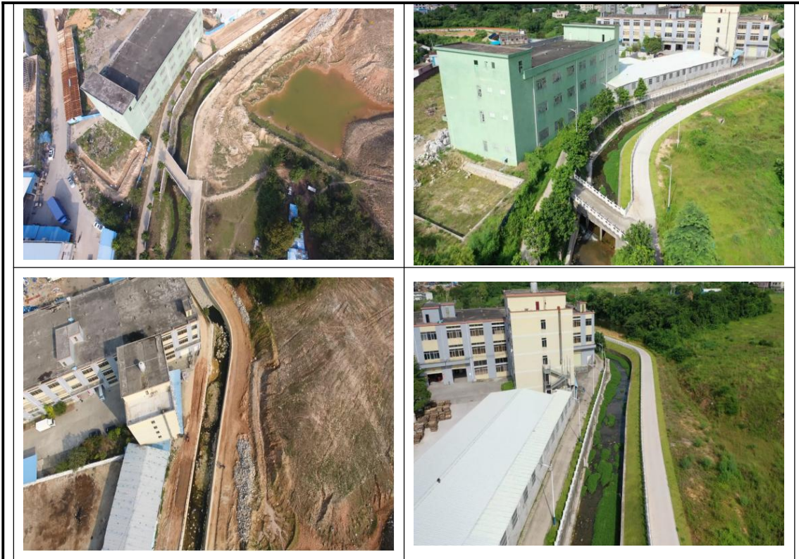
图 4-1 石溪河河道整治前后对比照片
