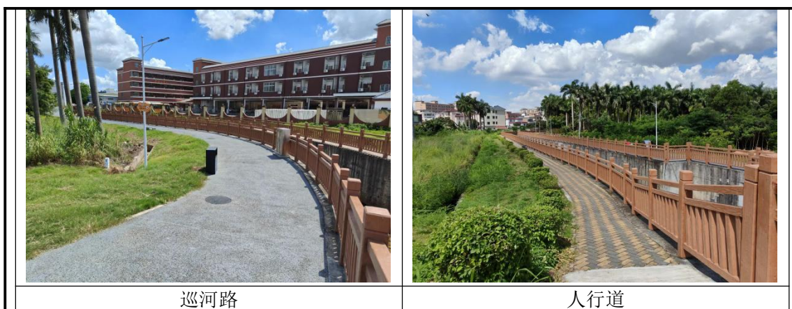
图 4-1 老鸦山水库排洪渠河道整治后照片
